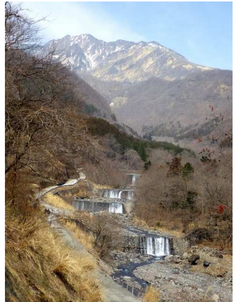
女峰山と砂防堰堤群
